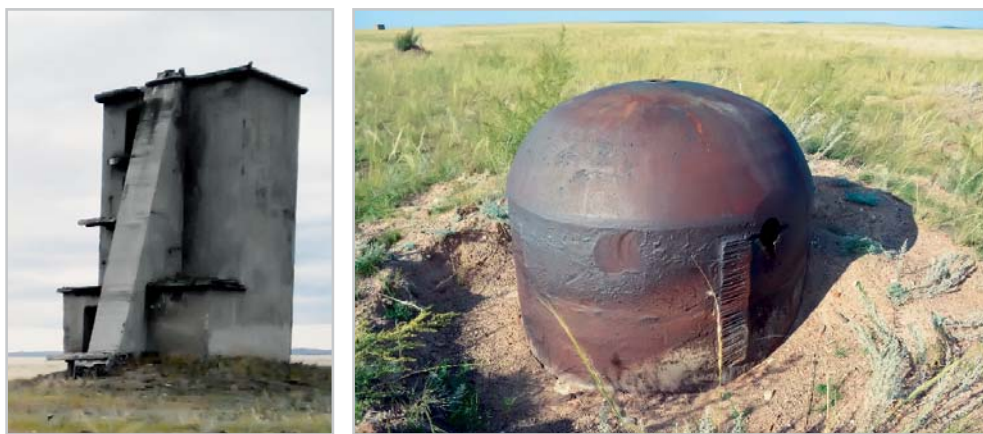
Рисунок 20. Мощное 4-этажное железобетонное приборное сооружение с ребром жесткости – «гусак». Расположено на технической площадке П-1. Справа – бронеколпак долговременной огневой точки (ДОТ).
