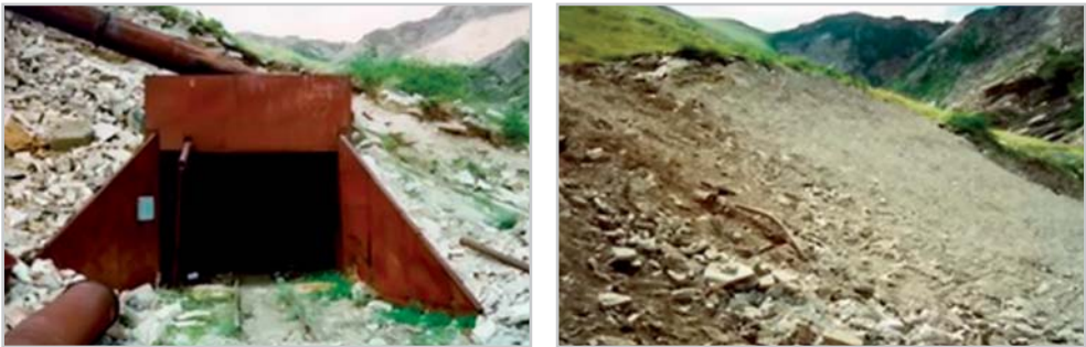
Рисунок 33. Портал штольни №022 до и после закрытия
