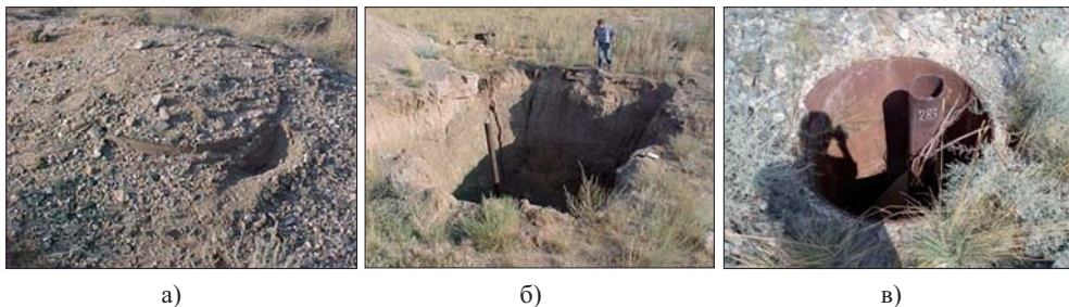
6-Сурет. Ұңғымалардың қазіргі ахуалының мысалдары: а – 128 ұңғ. (жабылған, бір бөлігі қазылған); б – 106 ұңғ. ( 5–6 м тереңдікке дейін қазылған); в – 283 ұңғ. (басылып шыққан тізбесінде жоқ)
